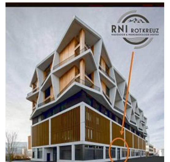
Das neue RNI Rotkreuz öffnet am 14. September ihre Türen für die Bevölkerung.
